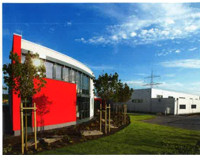
© 2014 Koblenzer Steuerungs- und Verteilungsbau GmbH
